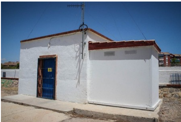
Depósito del Este
