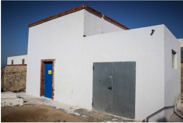
Depósito de Rocas Blancas
